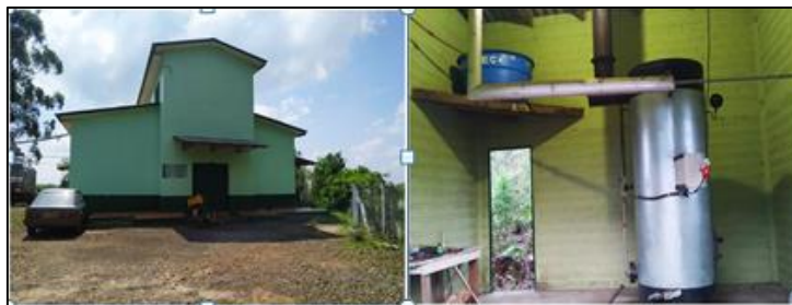
Ilustração 1: Prédio composto pela área de abate e caldeira de aquecimento
